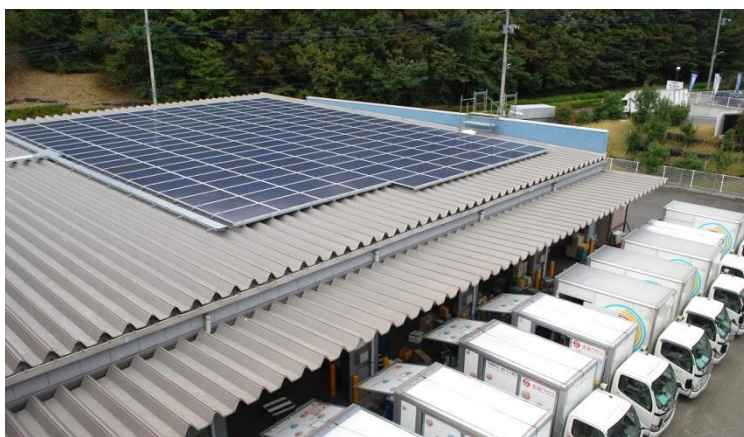
生活クラブ東京・多摩統合センターの太陽光発電設備
