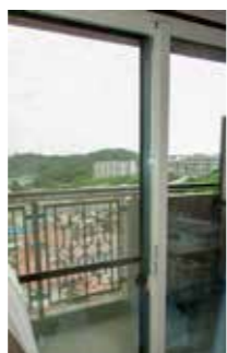
黒の既存サッシに 白い内窓を設置した事例
