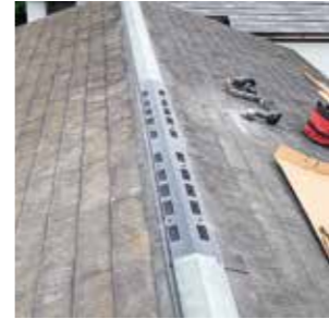
換気棟の取り付け例
