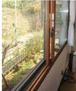
既存の窓の内側に高性能内窓を取り付けた例
