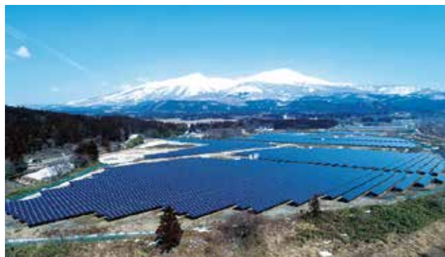
一般家庭の年間電気消費量に換算して5,700世帯分の電気を発電する、庄内・遊佐太陽光発電所。生活クラブのお米「庄内遊YOU米」の産地にあり、砕石工場跡地を利用しています。
