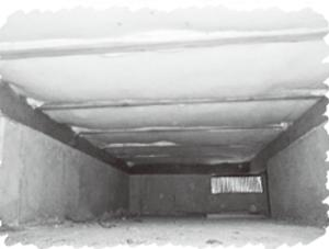
床下から既存断熱材の上にロール型断熱材を追加
