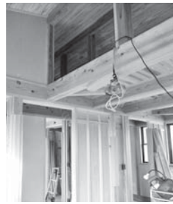
工事が完成すればロフト付きの心地よい空間に
