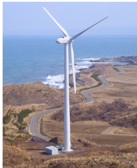
2012年に建設した生活クラブ風車「夢風」
