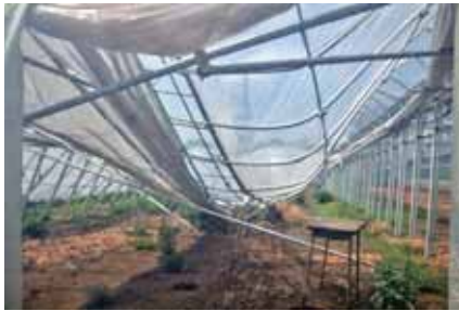
雪の重みでパイプが曲がったビニールハウス
