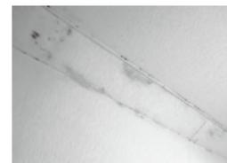
「北側の部屋の壁・天井にカビが発生」との相談をしばしばいただきます。原因は結露です。冬、コンクリートの冷たさが壁の表面にまで伝わり、そこに暖かい空気が流れ、結露・カビが発生します。対策として、セラミック断熱塗料「ガイナ」を塗ることで、結露・カビだけでなく冷気を防ぐことができます。しかも、空気中のにおいや化学物質も除去します。費用は6畳洋室で、壁天井クロス剥がし+カビ除去+「ガイナ」塗装で20万円台後半です。
